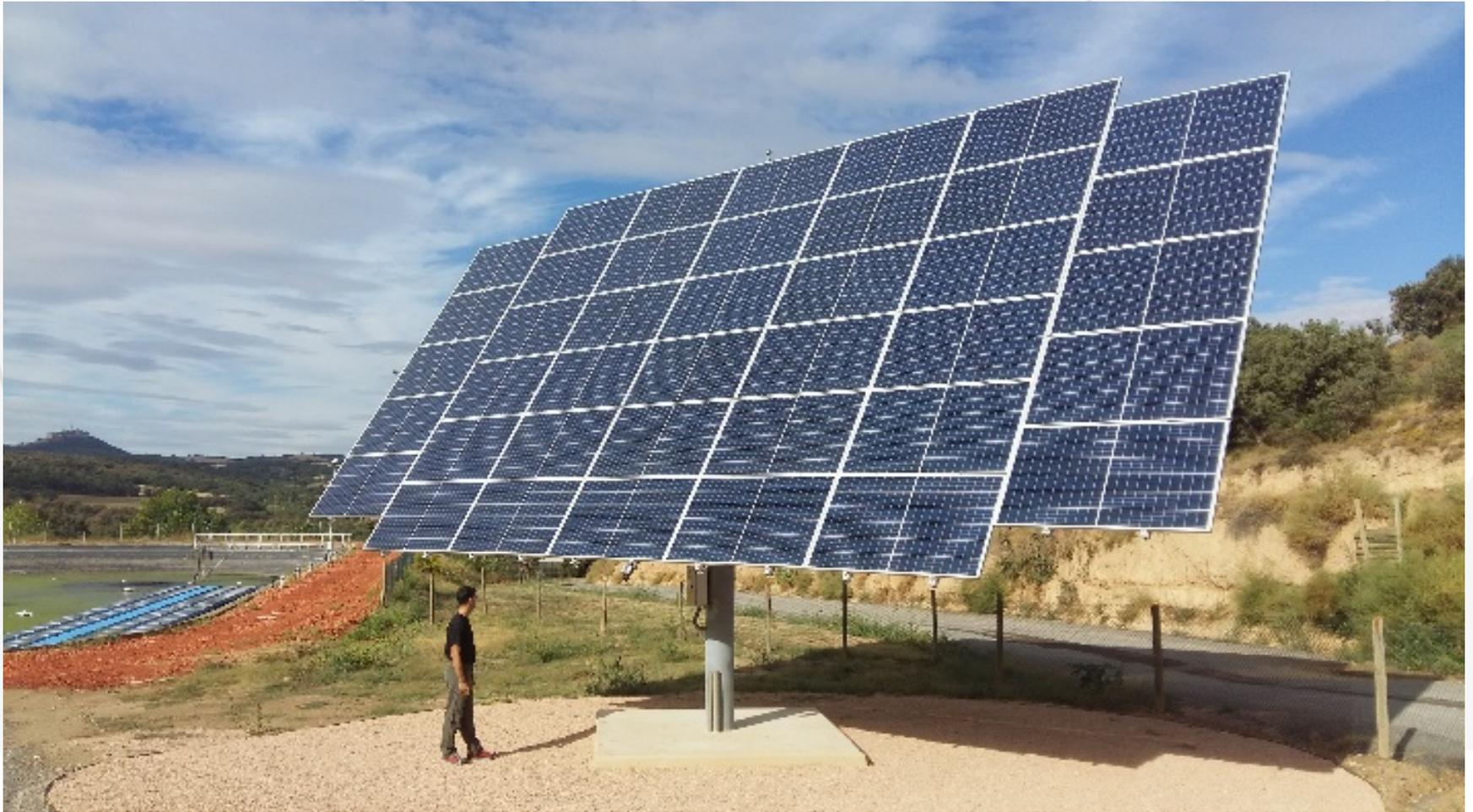
**Conjunto de paneles sobre seguidor solar**
