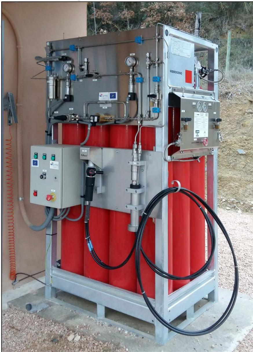
**Sistema de repostaje de hidrógeno**
